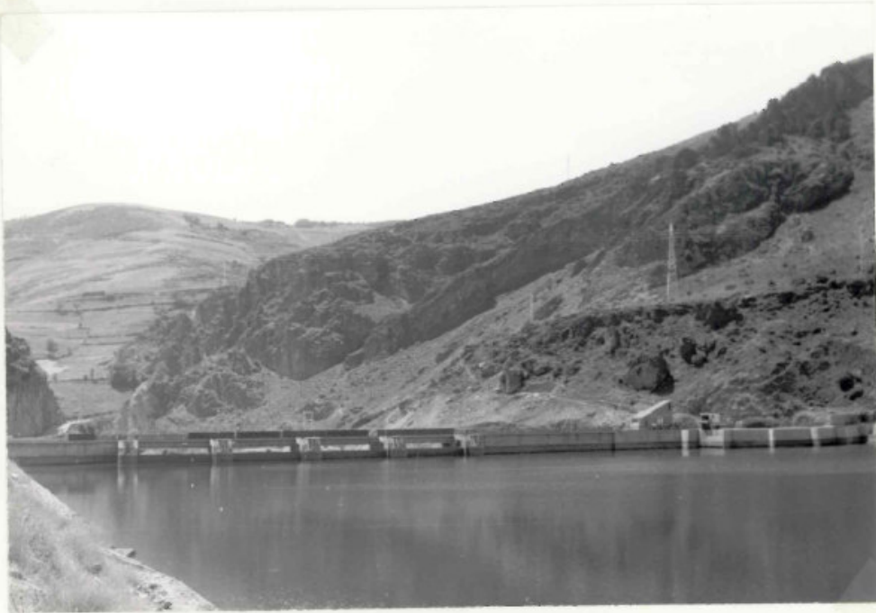
Panoramica presa desde aguas arriba.
