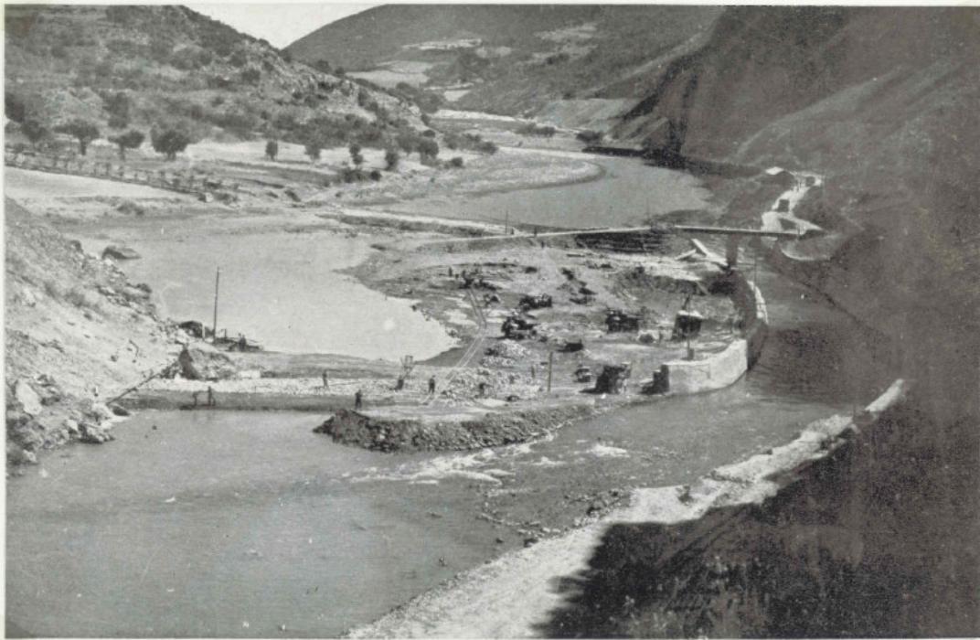
Vista panorámica antes de la construcción de la presa. Canal de desvío.
