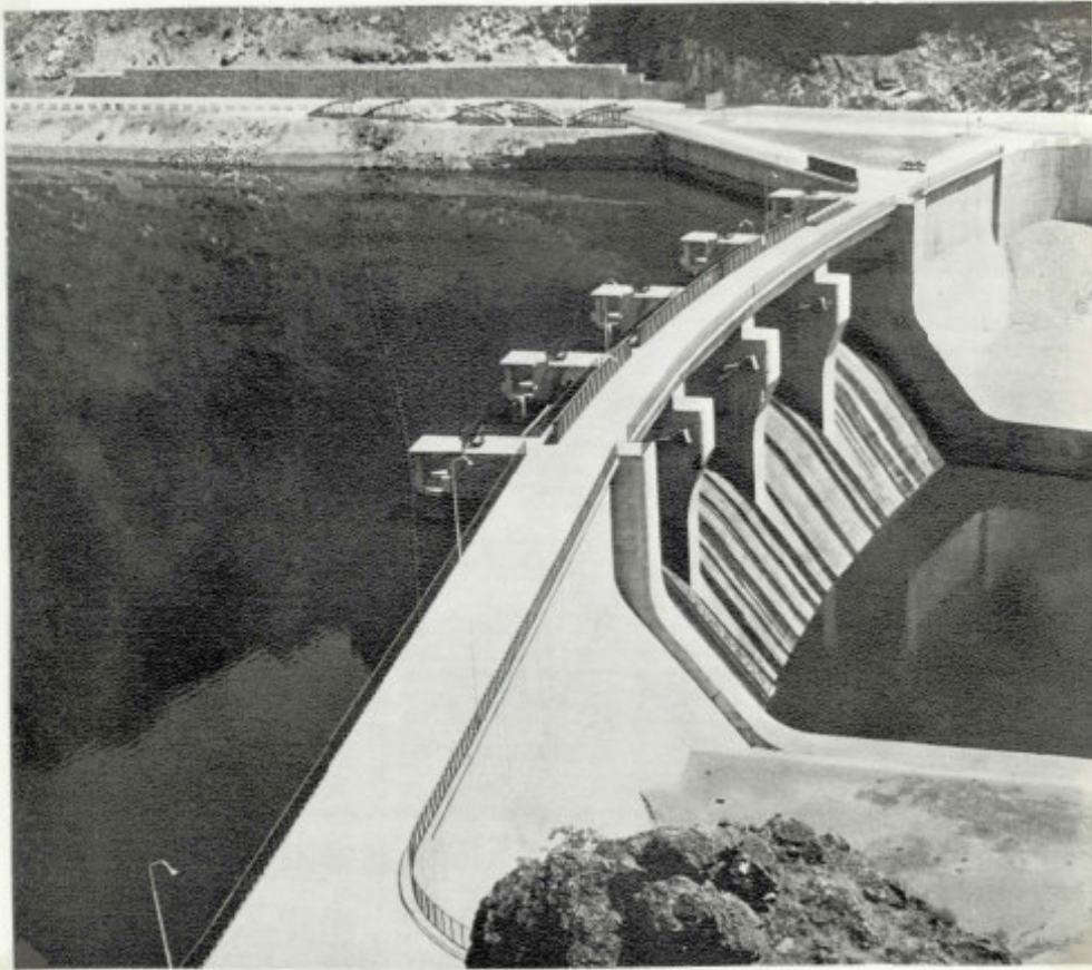
Paso por coronación y aliviadero aguas abajo.
