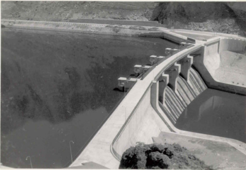
Vertedero y pozos hidrostáticos.
