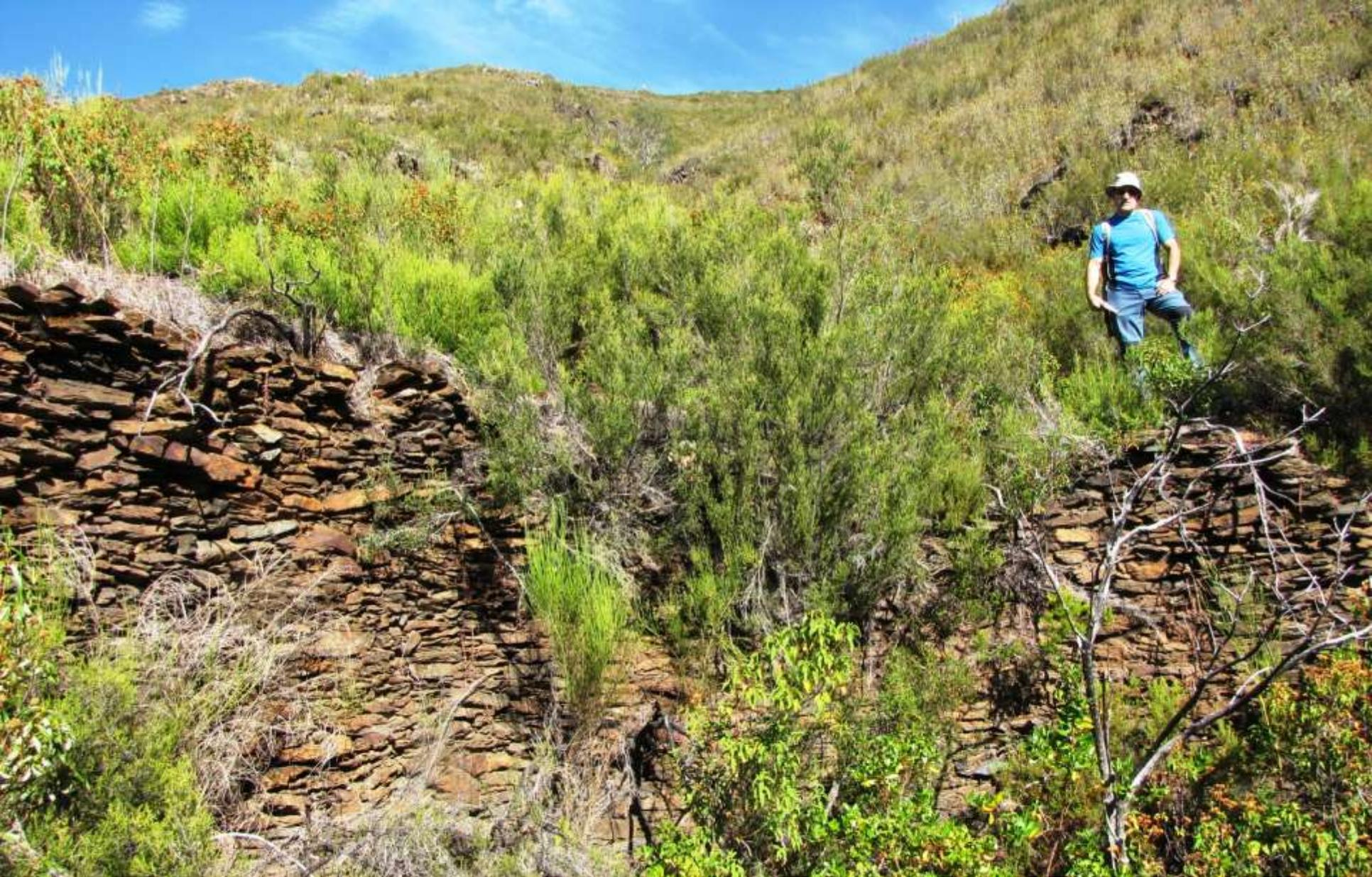
*Muro robusto de canal salvando una vallina. El agua ocasional que desagua la vallina se incorpora al canal, el sobrante, se evacuaba fuera del cajero del canal sin hacer daño al mismo.*
