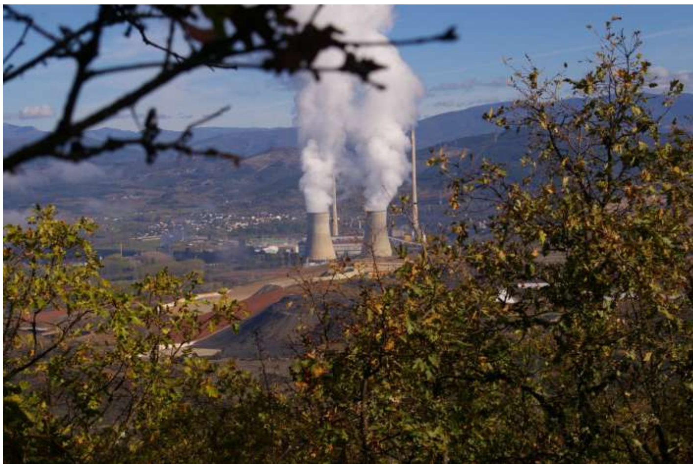
Perspectiva de la central térmica de Compostilla II vista desde la cima del Castro de San Andrés de Montejos.
