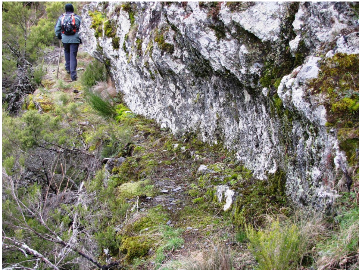
Traza del canal alto tallado sobre roca, una vez se rebasa el arroyo de las Furnias (o de Pico Tuerto).
