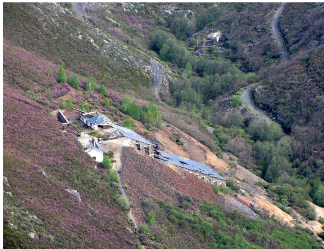
Minas de Valborraz: Lavadero de las minas con seis niveles de trabajo. A la parte alta llegaba el mineral en bruto en vagonetas. Después, por gravedad, pasaba a través de diferentes procesos: molienda, lavado, decantación, etc. Finalmente, las mesas vibratoras separaban los minerales pesados. El wolframio quedaba diferenciado del resto de los materiales por ser mucho más denso y paramagnético.
